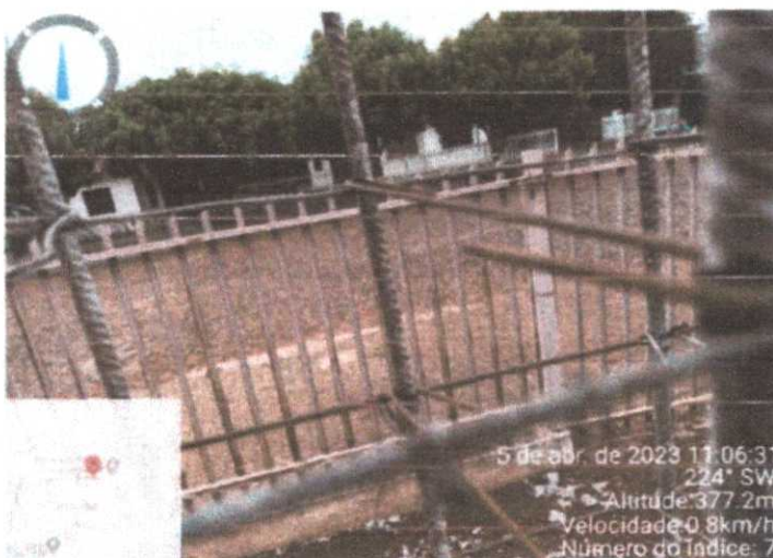
Foto 06 : pilar P39 com os estribos suplementares dobrados
